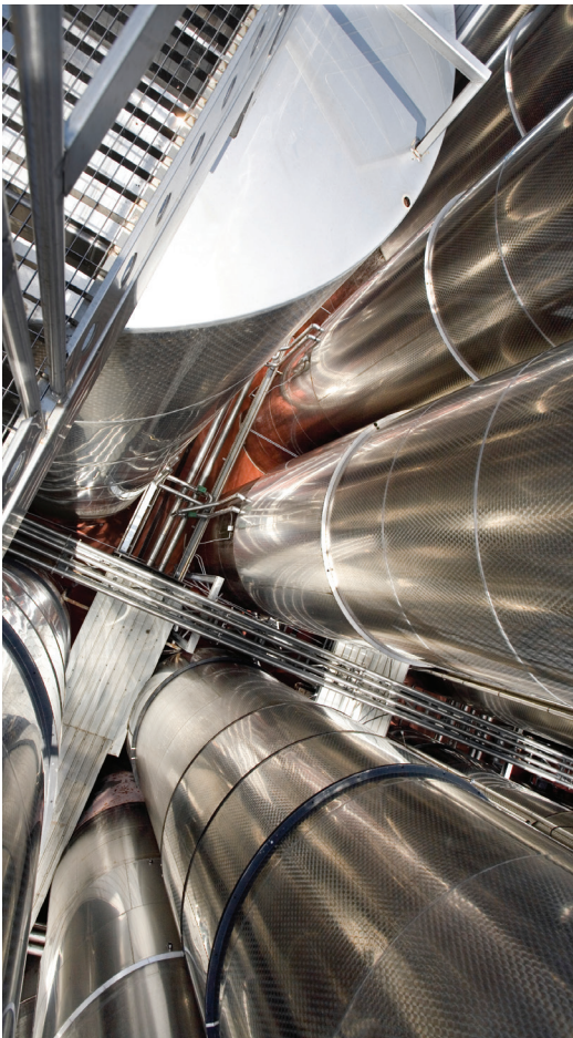
Silos, cuves et trémies
